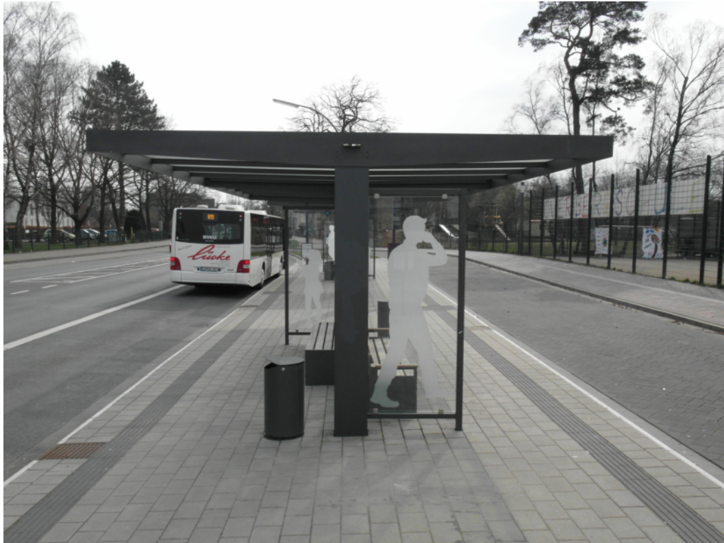
Beispiel für Haltestelle in Mittellage (BusPort). Hier genügend Breite und besserer Witterungsschutz
