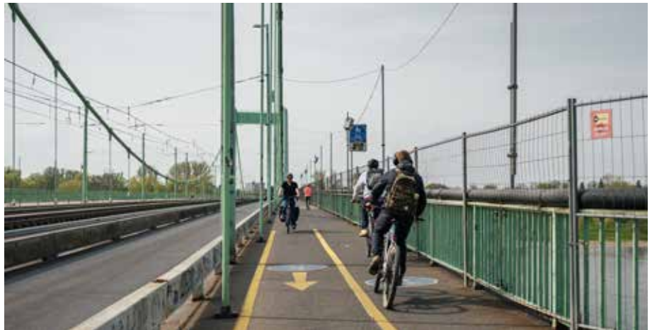
Mülheimer Brücke während der Sanierung: Für den Fuß- und Radverkehr wurde es eng. Trotz Beschränkung auf nur eine Spur floss der Kfz-Verkehr, auch nennenswerte Verlagerungen der Verkehrsströme wurden nicht festgestellt.
