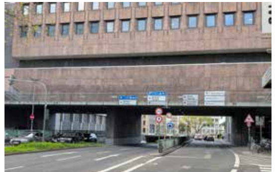
Die Süd-Fahrt am WDR-Hochhaus – prägnantes Beispiel für die Umgestaltung Kölns zur autogerechten Stadt in der Nachkriegszeit. Angesichts solcher Stadträume sind die teilweise heftigen Widerstände gegen die Abkehr von einer autofixierten Verkehrspolitik nur verwunderlich.
