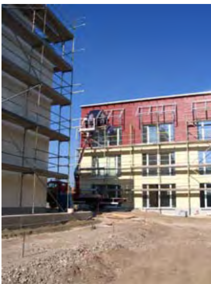
An einem Solarpassivhaus wird ein Sonnenkollektor montiert
