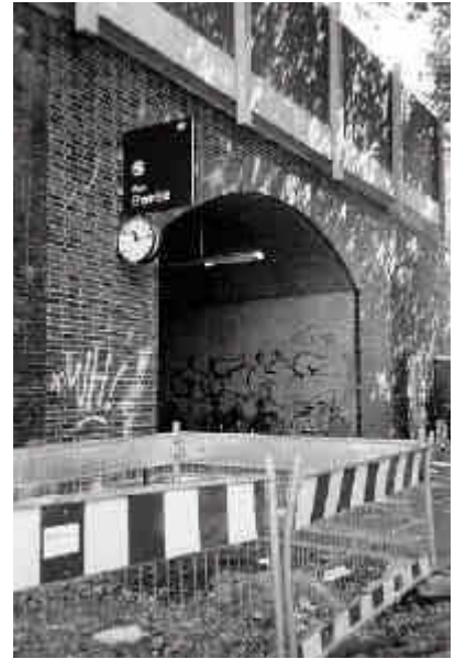
Bahnhof Ehrenfeld: Wo ist der Zugang?
