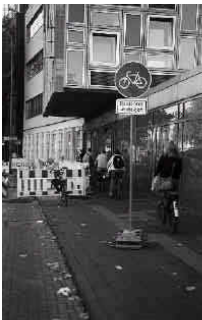
Baustellen und Radverkehr I: Standardlösung „Radfahrer absteigen“
