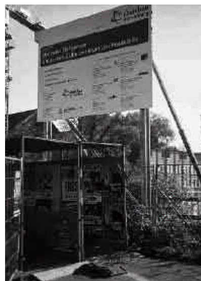
Baustellen und Radverkehr II: Auch kein Vorbild – Fuß- und Radweg an der im Bau befindlichen Tiefgarage am Neumarkt
