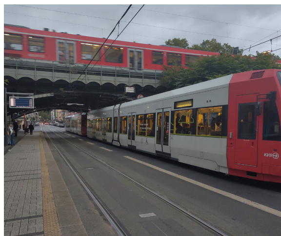
Die Brücken über die Venloer (oben), die Zülpicher (unten) die Vogelsanger und die Luxemburger Straße müssen saniert werden.
