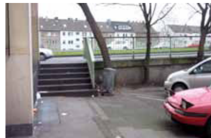
Eine Rampe anstelle der Treppe an der Nordseite der Brücke in Mülheim ist leicht eingerichtet und bietet – nicht nur – Radfahrern mehr Komfort.
