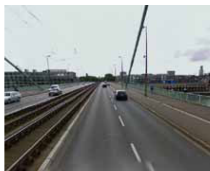
Severinsbrücke: autogerechten Stadt
