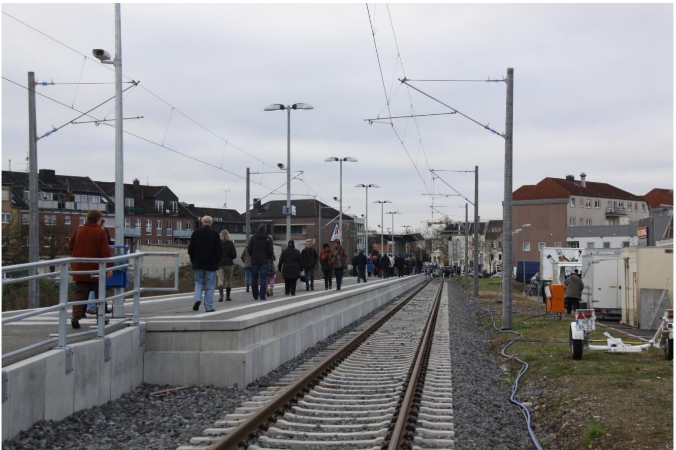
Der neue Bahnsteig in der Kreistadt Heinsberg (Foto Roland Stahl 15.12.2013)
