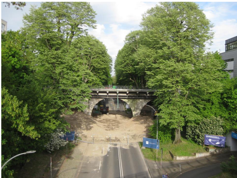
Abrissbaustelle der Brücke Betrather Straße
