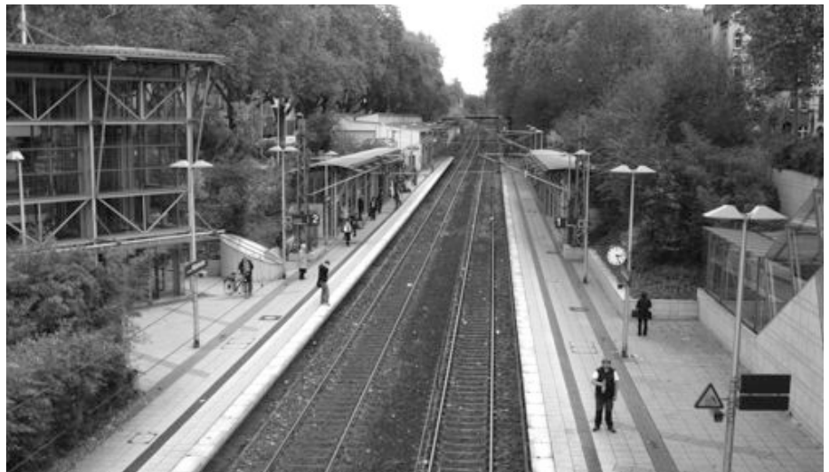
Blick von der Möllerbrücke auf die Bahnsteige: Sie sind breit genug, teilweise überdacht und verfügen über ein Blindenleitsystem.
