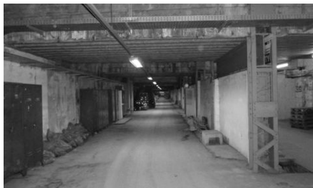
Der Posttunnel ist circa 6 Meter breit. Der rechte Tunnel mit den Aufzügen endet als Sackgasse in Höhe der Treppe des Fußgängertunnels im Norden.
