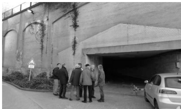
Der nördliche Tunnelausgang auf dem Postgelände vor dem Pfortner weiter links.
